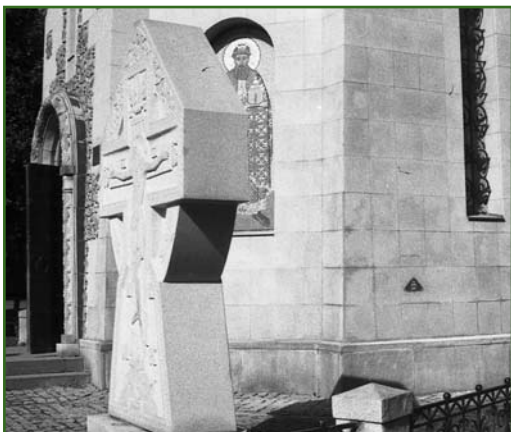
Рис. 3 Восстановленная нивелирная марка № 2210 на южной стене часовни святого благоверного князя Даниила Московского
